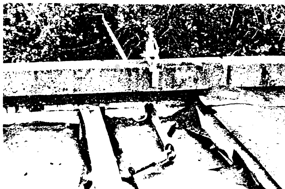
Fig. 10. TV-inspektion (tagplade fjernet). Kameraet kan drejes, hvilket muliggør detaljerede undersøgelser.
